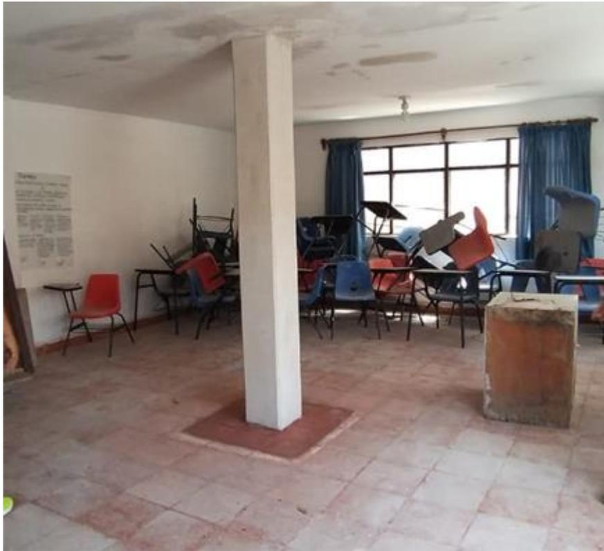
**Figura 20: Columna colocada en salón 5 como refuerzo a la losa.**
